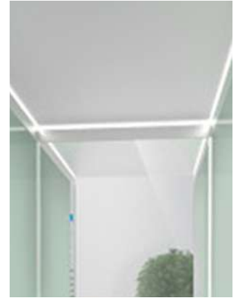
Iluminación en techo
