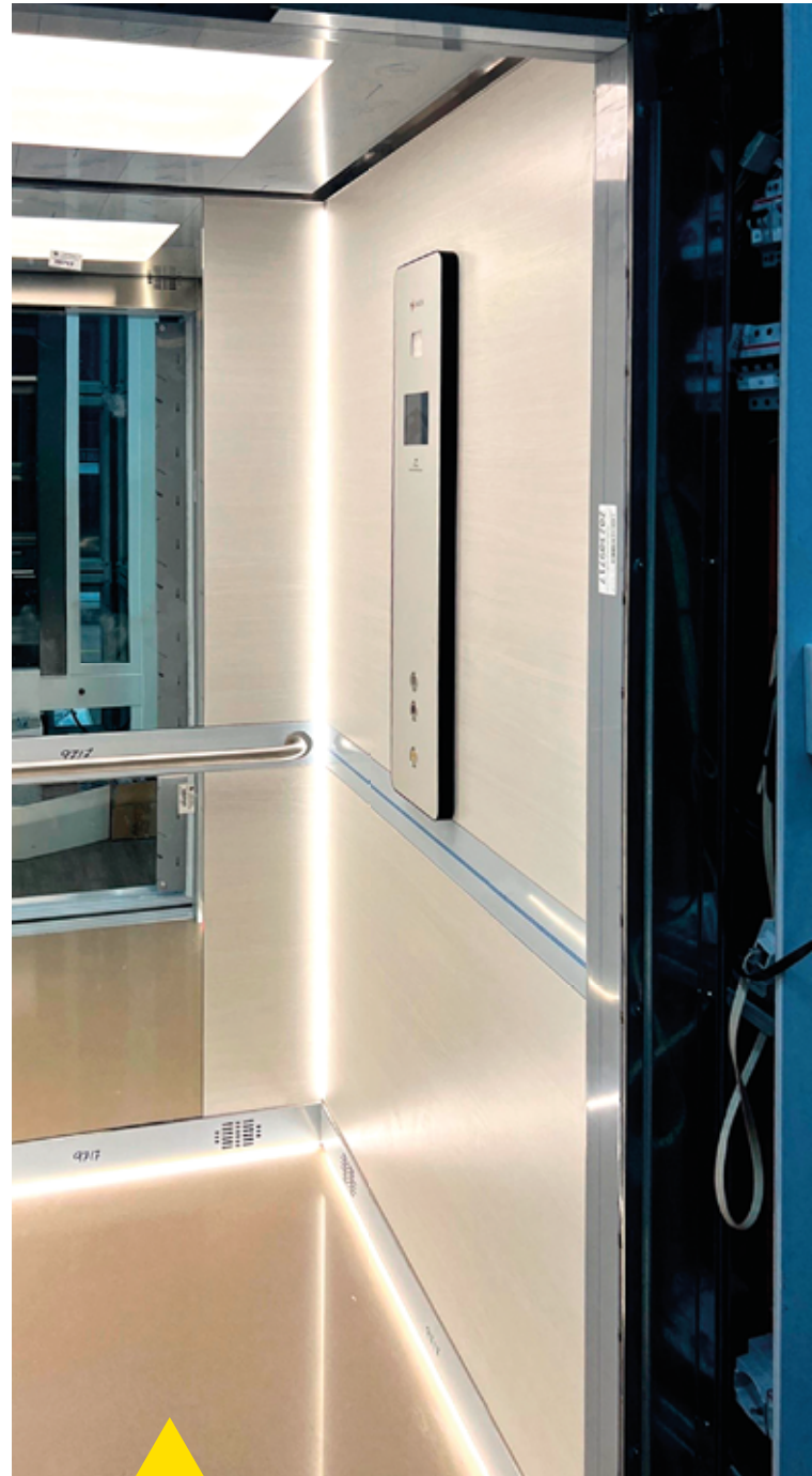
Zargensteuerung und Kabinenausstattung.
