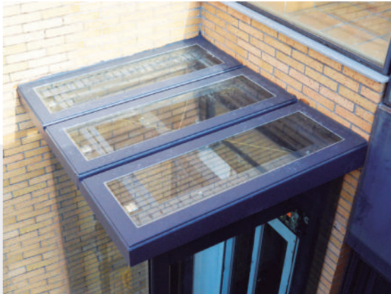
Dach (Blech oder Glas)
