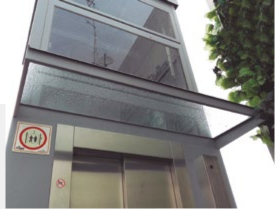
Canopy over door (metal sheet or glass)
