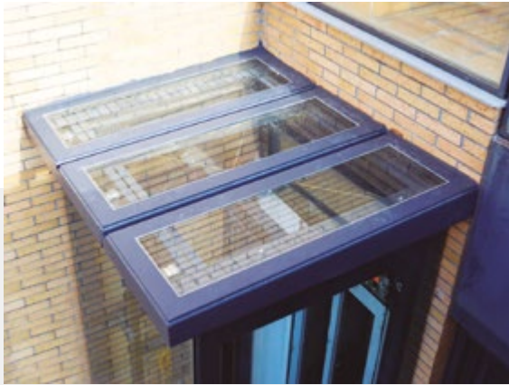
Dach (Blech oder Glas)
